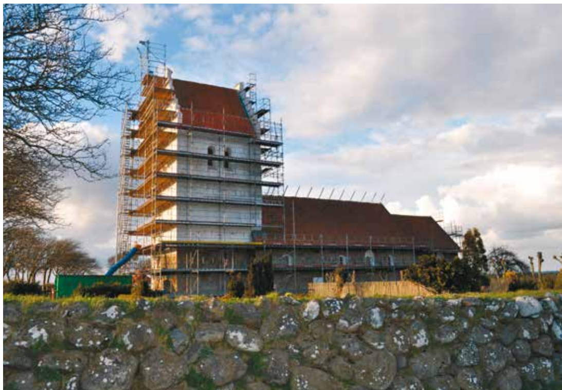
Tømmerby Kirke. April 2015. Klar til at få genopbygget den tabte kamtak, samt få lagt nyt tag på.
