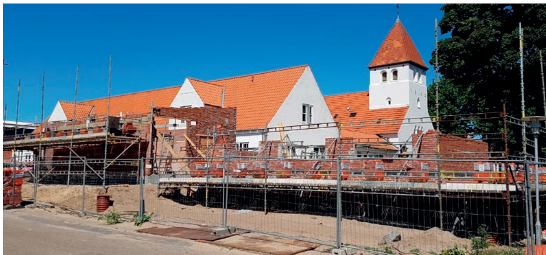
Tilbygningen til Bangsbostrand Kirke tager form midt i juliheden
